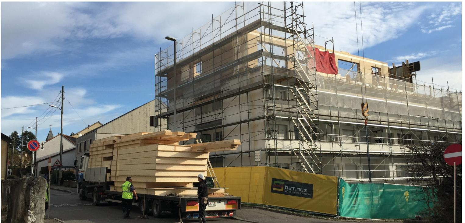
Puis la structure a été renforcée par la mise en place de lames de carbone collées sur la dalle de la toiture existante. Les nouvelles façades en panneaux préfabriqués Batiflex™ ont été posées, quand à la toiture elle a été réalisée à l'aide de caissons préfabriqués bois isolés. Les cages d'escalier ont été prolongées, afin d'accueillir les marches du nouvel étage.
