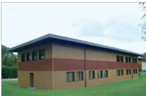
Vue arrière du bâtiment
