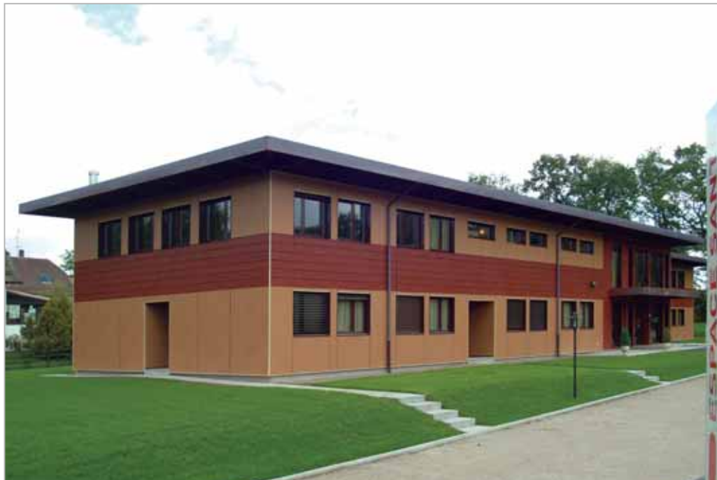
Nouveau bâtiment réalisé en structure bois lamellé collé
