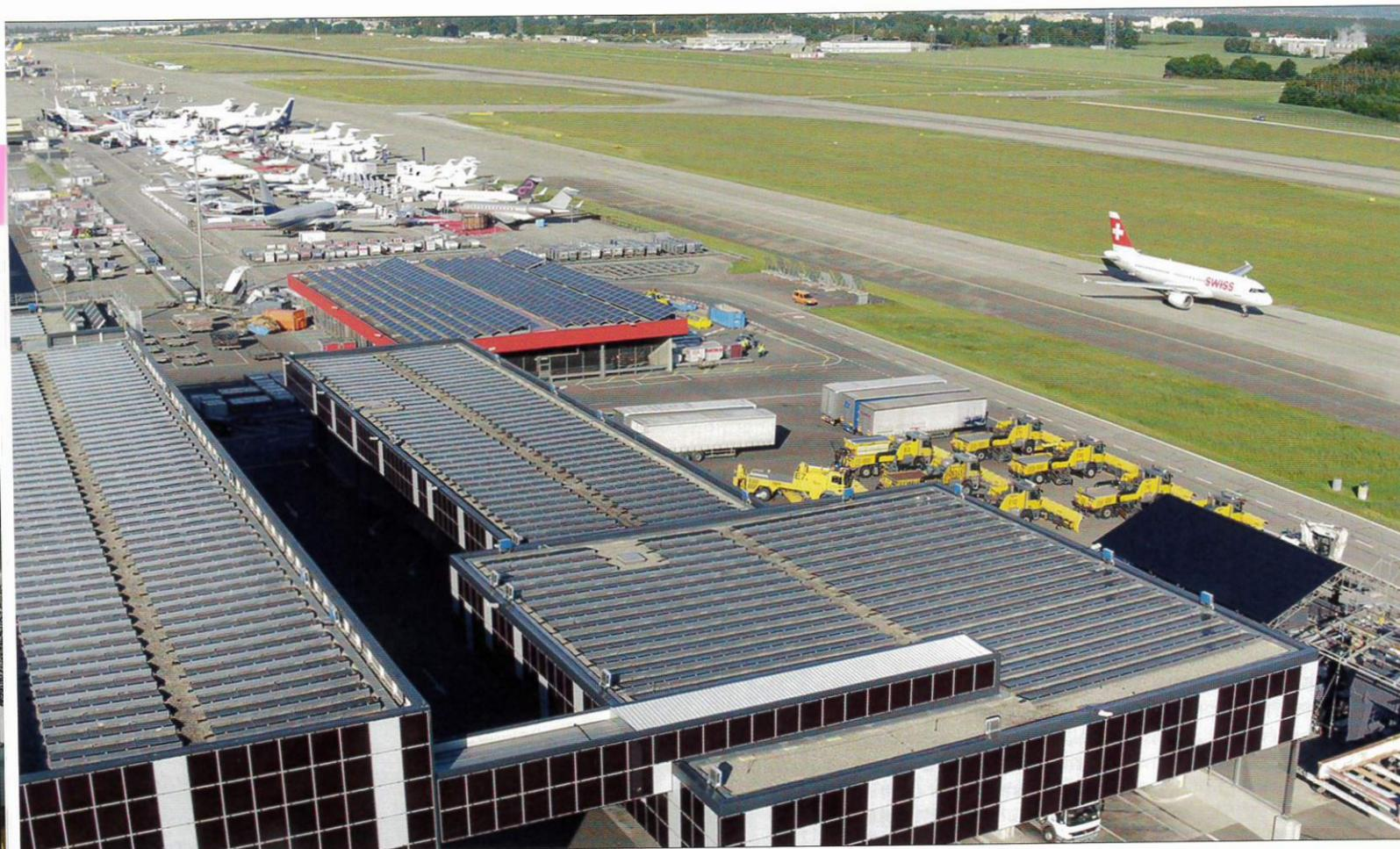
La station de distribution de carburants et de produits de dégivrage ADIC, construite en 2013, est recouverte de panneaux solaires en toiture. A ce jour, le site aéroportuaire totalise une surface de plus de 10 000 m<sup>2</sup> pour une production totale d'électricité de plus de 1000 MWh/an et une production totale d'énergie thermique de plus de 620 MWh/an.
