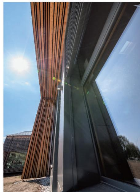
impressionnantes en lamellé-collé. Les pignons et la façade principale sont composés d'éléments préfabriqués à ossature bois (concept Batiflex).
