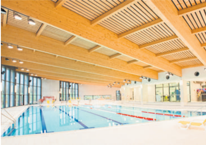
La charpente de la piscine de Chéserey est en bois suisse.
