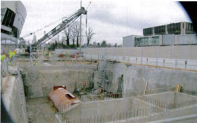
A deux pas de la station-service, devant l'Arena et le Centre Swissair, les travaux préparatoires à l'Aile Est ont débuté, ainsi que la réalisation d'un nouveau séparateur d'hydrocarbures. (photos PR)
