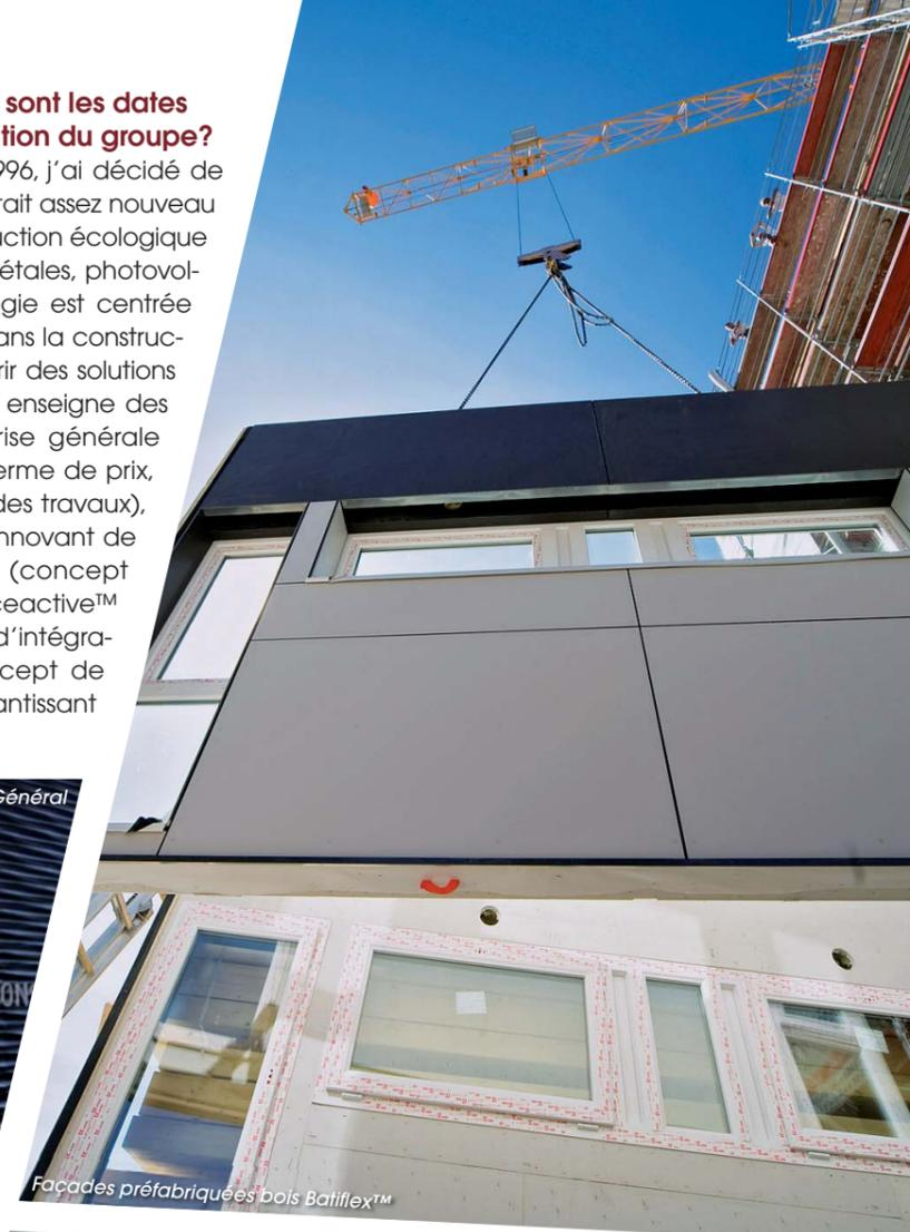
Surélévation de 2 niveaux et façades photovoltaïques Faceactive™ - Rue de la Colette - Meyrin
