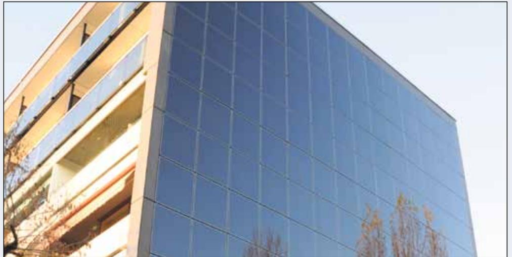
► **Façade photovoltaïque, toit végétalisé... un exemple d'économie d'énergie réalisé par Batineg...**
