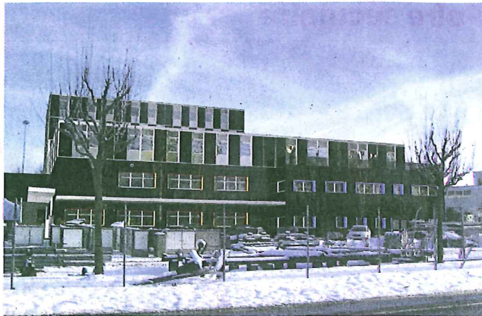
Un étage sera ajouté au bâtiment actuel, alors qu'une nouvelle construction sera accolée à l'arrière. PHOTOMONTAGE/BATINEG
