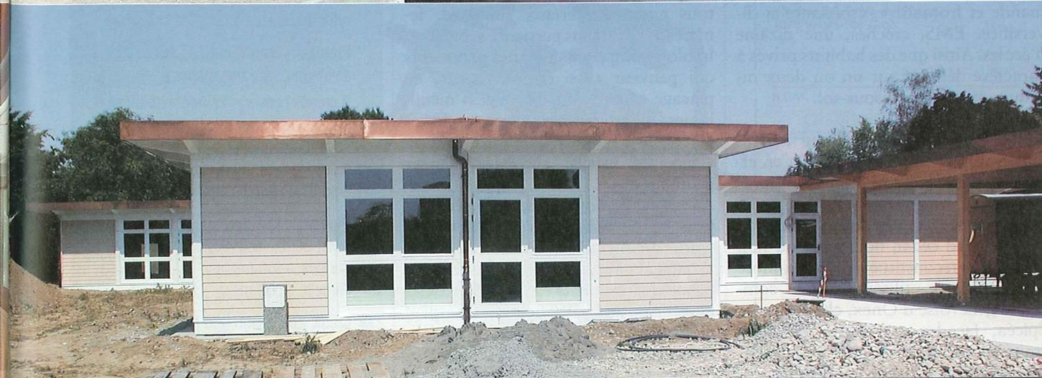
La construction en éléments préfabriqués n'empêche pas la variété des réalisations. Conformes aux exigences du Département genevois de l'instruction publique, les pavillons offrent l'avantage d'être construits dans des délais particulièrement brefs.
