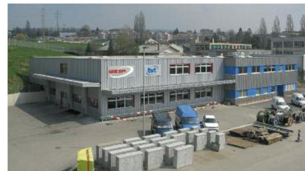
L'ancien bâtiment de Crissier (ci-dessus) a été rehaussé, agrandi et rénové. L'édifice répond désormais aux standards Minergie et ses éléments de façades non vitrés produisent de l'électricité.
