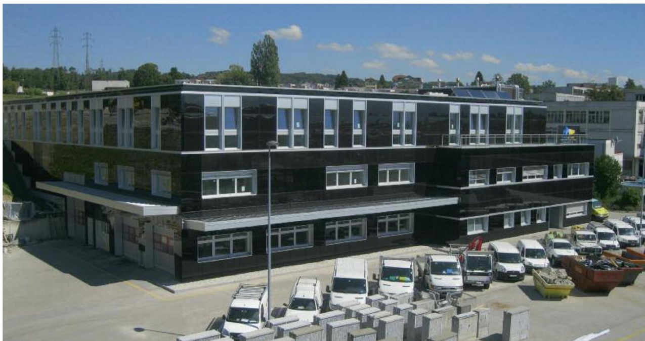
L'ancien bâtiment de Crissier (ci-dessus) a été rehaussé, agrandi et rénové. L'édifice répond désormais aux standards Minergie et ses éléments de façades non vitrés produisent de l'électricité.
